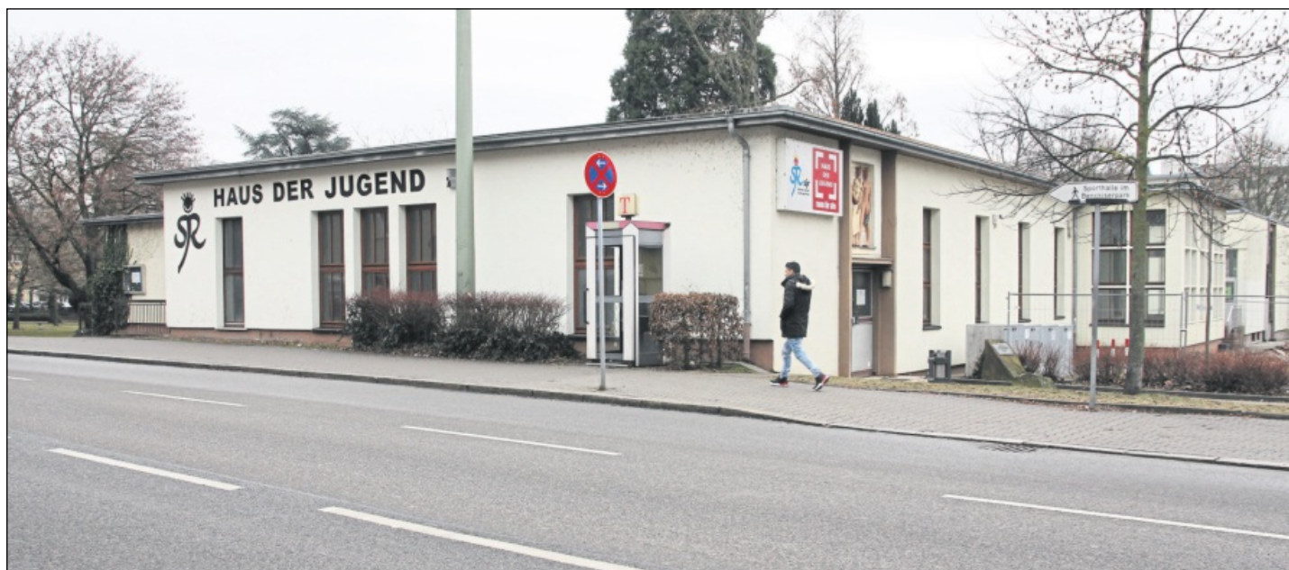
ES KANN LOSGEHEN: Die Stadt bekommt die geplanten Zuwendungen. Vorbereitende Maßnahmen hat man beim Haus der Jugend am Benckiser Park bereits getroffen: Das Gebäude ist entkernt worden. Foto: Ehmman
