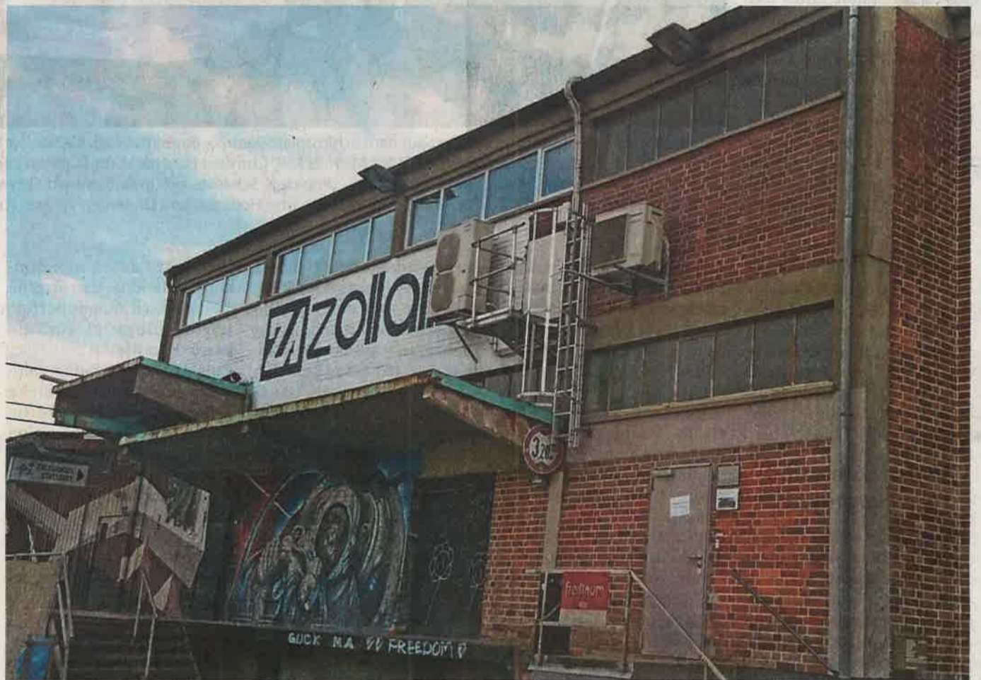
Nord- und Westflügel des Zollamts bleiben wie geplant erhalten und sollen mit ergänzenden Neubau-Teilen ein stadtteilprägendes Ensemble bilden. Foto: Iako/arc
